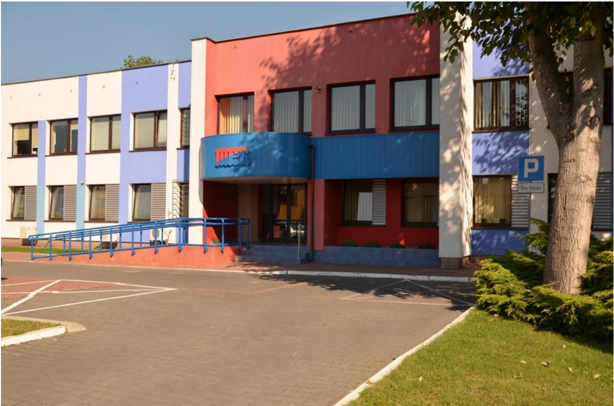
Wejście główne do budynku administracyjnego
